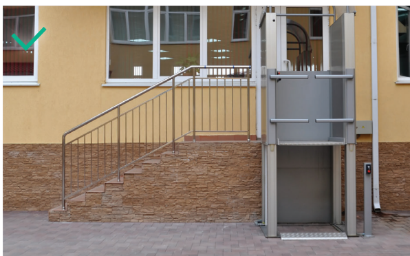
Входная группа оборудована подъемником.
