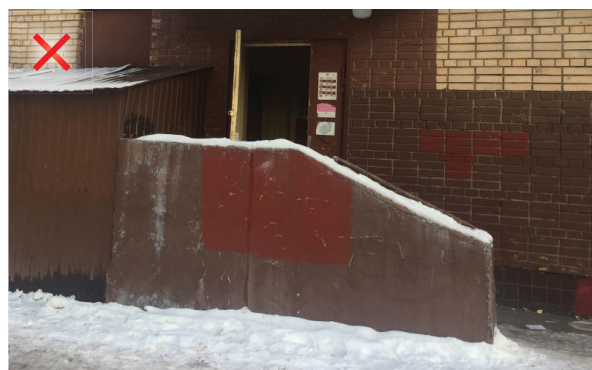
Ограждения выполнены из непрозрачных материалов.
