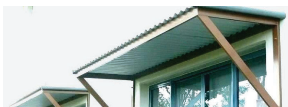
Козырек на кронштейнах.
