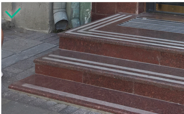
По краям ступеней наклеены абразивные ленты.
