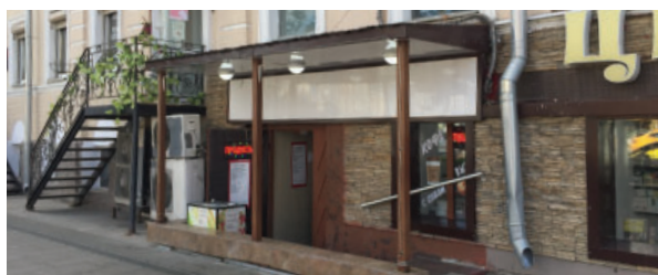
Козырек на опорах.
