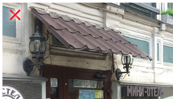
Козырек выполнен из металлочерепицы.
